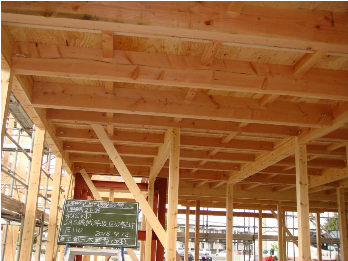
<梁：米松 KD JAS 機械等級区分構造用製材 E110>
